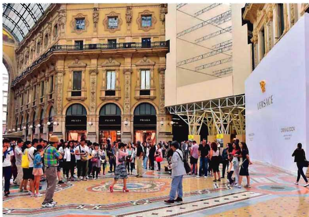
Restyling in Galleria. I turisti si fanno fotografare nell'Ottagono dove sono in corso lavori di restauro
